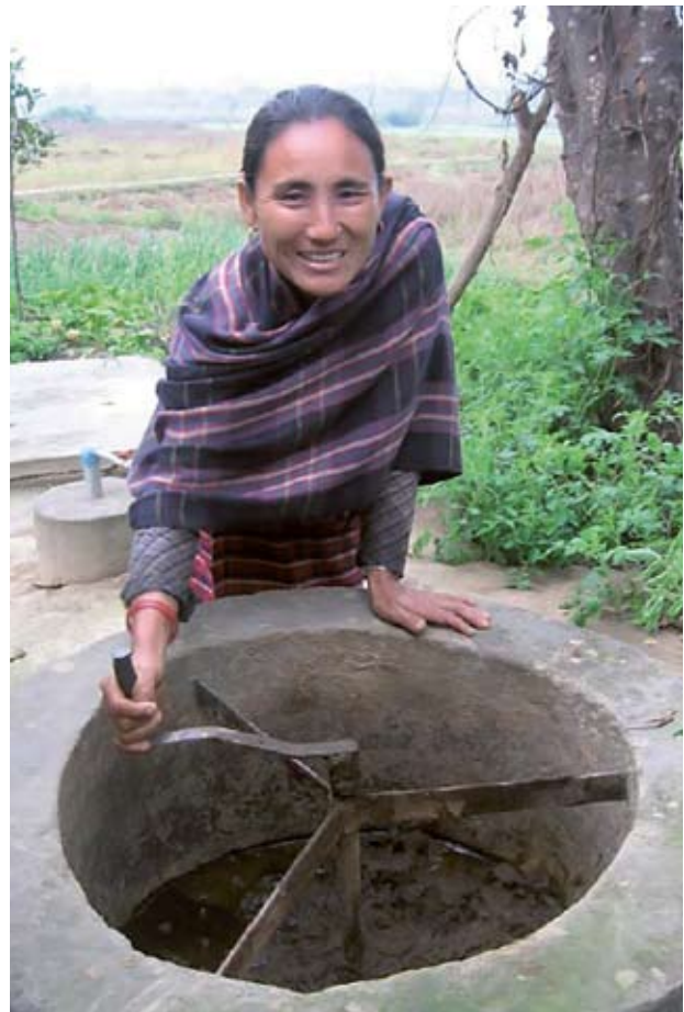
Um Tier- und Pflanzenarten in Nepal zu schützen, errichtet der WWF in nepalesischen Dörfern Biogasanlagen.
